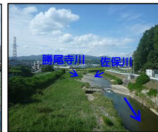
③ 幣久良橋より上流
