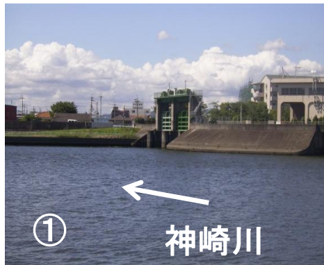
旧猪名川水門及びポンプ場
