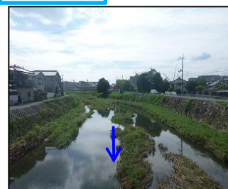
① 中河原橋より上流
