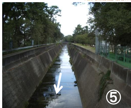
⑤ 水路橋上流
