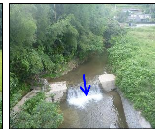
⑥ 上流端付近
