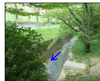
④ 無名橋より上流
