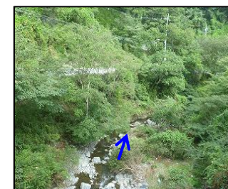
③ 上流端付近
