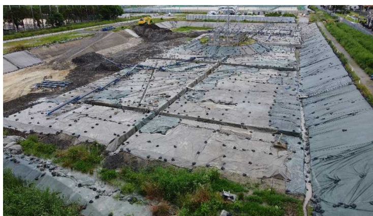
① 文化財掘削状況(令和4年6月6日時点)
