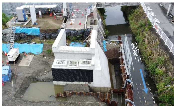
② 橋台完成状況(令和4年6月6日時点)
