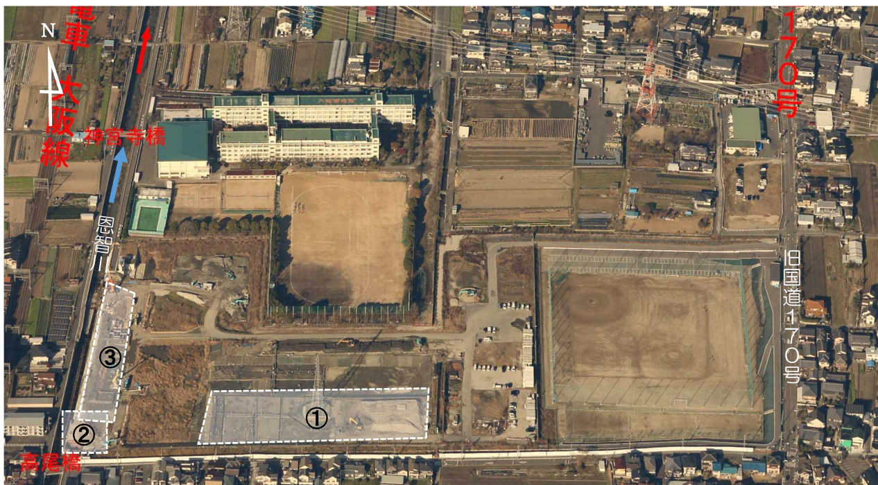
恩智川（法善寺）多目的遊水地 全景写真（令和3年12月）
