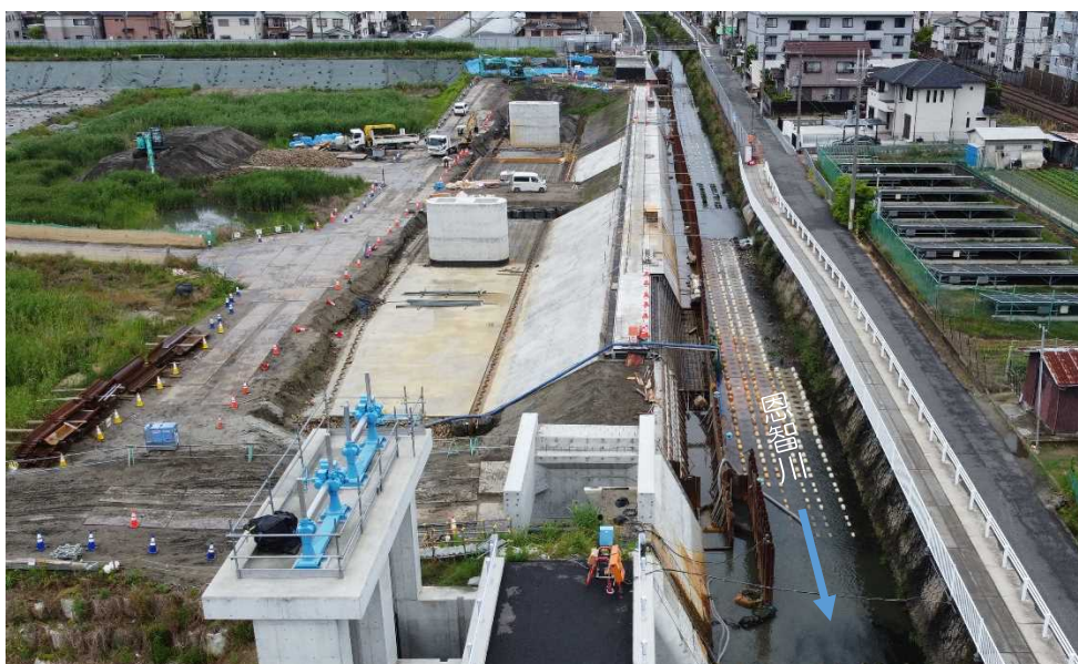
③ 越流堤(※)施工状況(令和4年6月6日時点)
