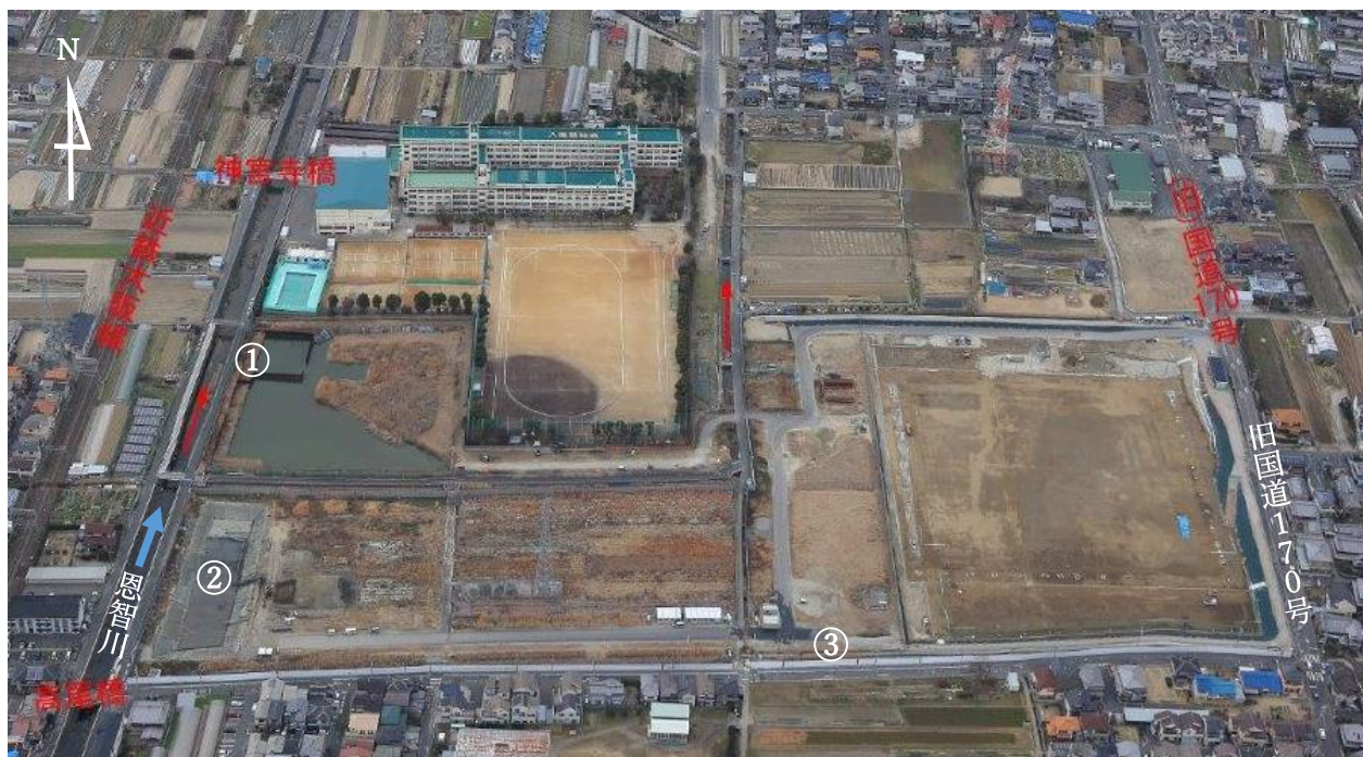
恩智川（法善寺）多目的遊水地全景写真
