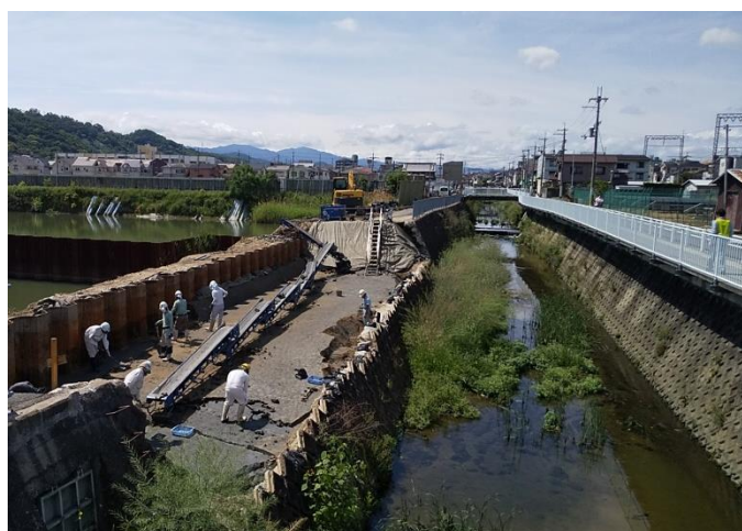
① 堤防撤去状況(令和元年5月末時点)
