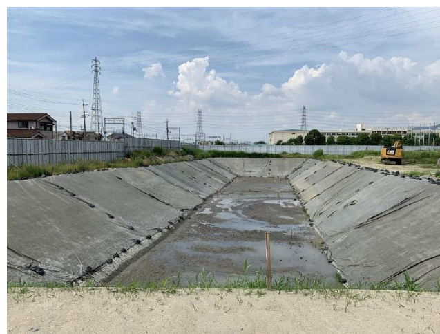
② 掘削状況 (令和元年5月末時点)
