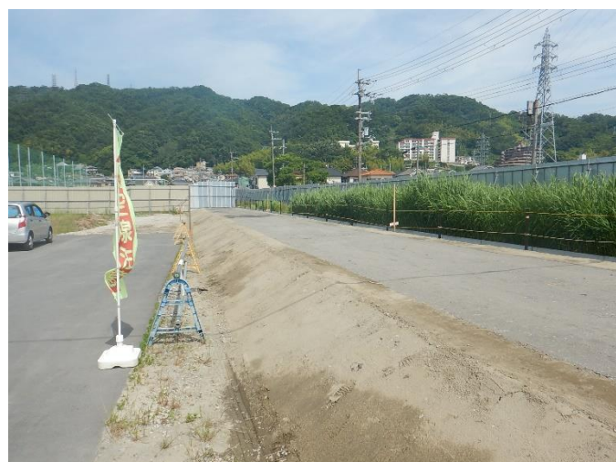
③ 周囲堤施工状況(令和元年5月末時点)
