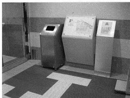
・点字等による案内板 図面は、晴眼者にも使えるように、彩色され、墨字の表記もされている。風除室内に設置され、視覚障害者誘導用ブロックにより誘導している
