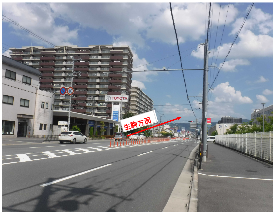
【1期区間】南側概成状況
