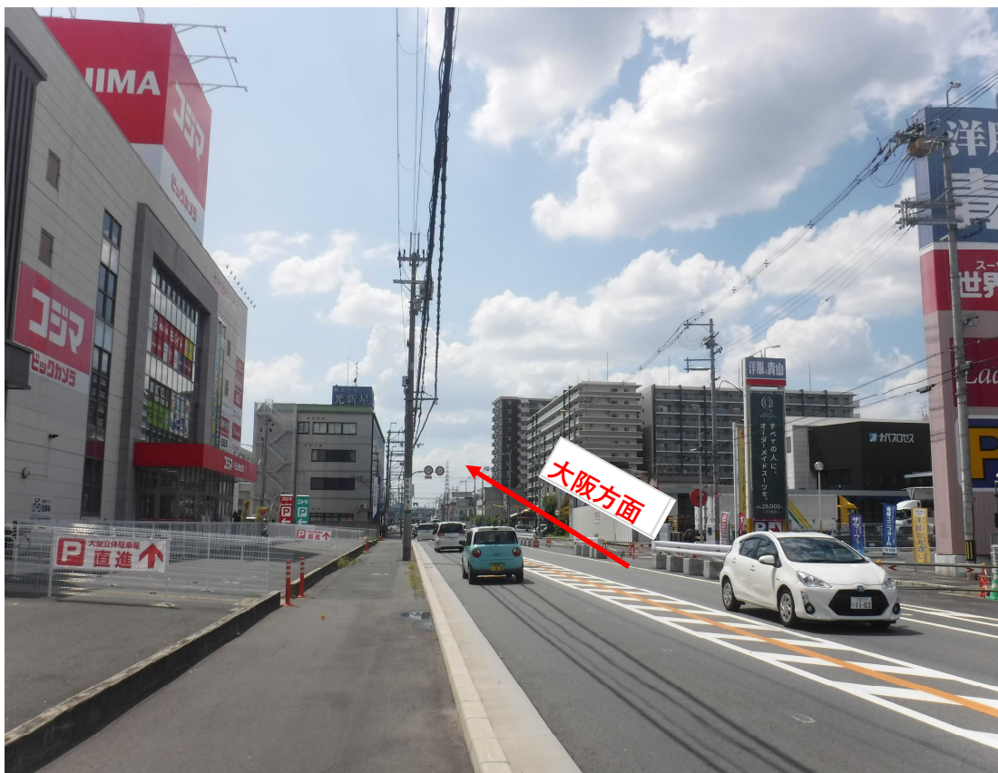
【2期区間】南側工事状況
