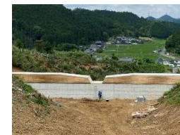
堆砂容量のある治山ダムの設置
