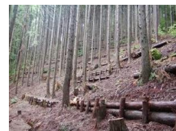
本数調整伐と筋工の施工
