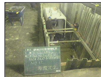
令和6年度施工写真
