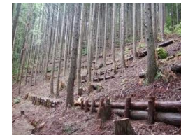
本数調整伐と筋工の施工
