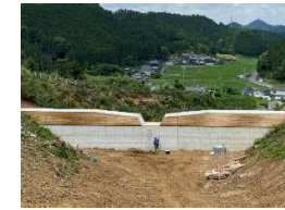
堆砂容量のある治山ダムの設置
