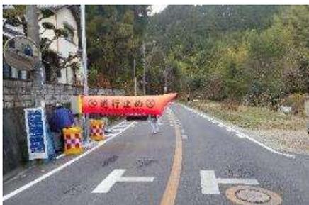
空気式遮断機による通行規制
