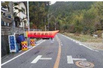
空気式遮断機による通行規制
