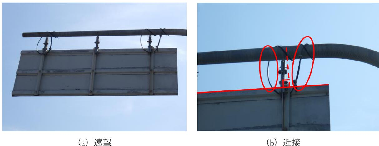
図付 10-1 不適切な標識板落下防止ワイヤーの設置状況例（たるみ及び余分な設置角度）
