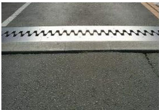
図3-9 段差発生状況写真
