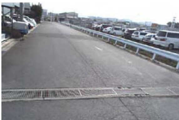
図3-9 段差発生状況写真
