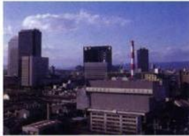
上空からの写真(南東から)
