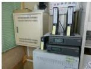
停電により電話のデジタル交換機が使えず、外部との連絡が取れなくなったため、電気自動車からデジタル交換機へ給電
