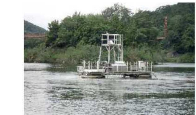
写真 4.1-2 浅層曝気循環設備 (室生ダム)
