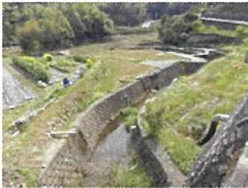
施工対象外区間
