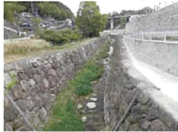
施工区間(上流)
