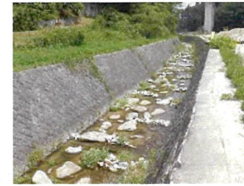
水制工の設置（流れの多様性の創出）
