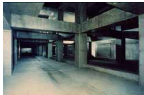
三ッ島調節池
