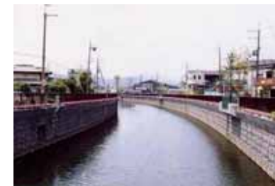
寝屋川導水路
