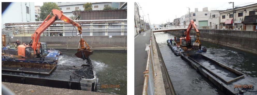
図 5.20 底泥の浚渫(平野川)
