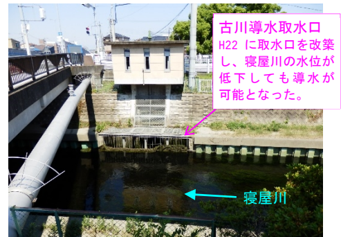
図 5.8 古川導水路の呑口部
