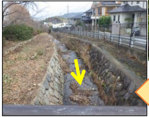
四條畷市 北谷川 (溪流保全工内の伐採)
