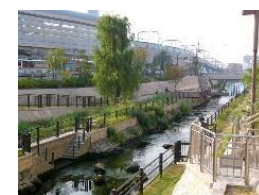
親水護岸整備(寝屋川)
