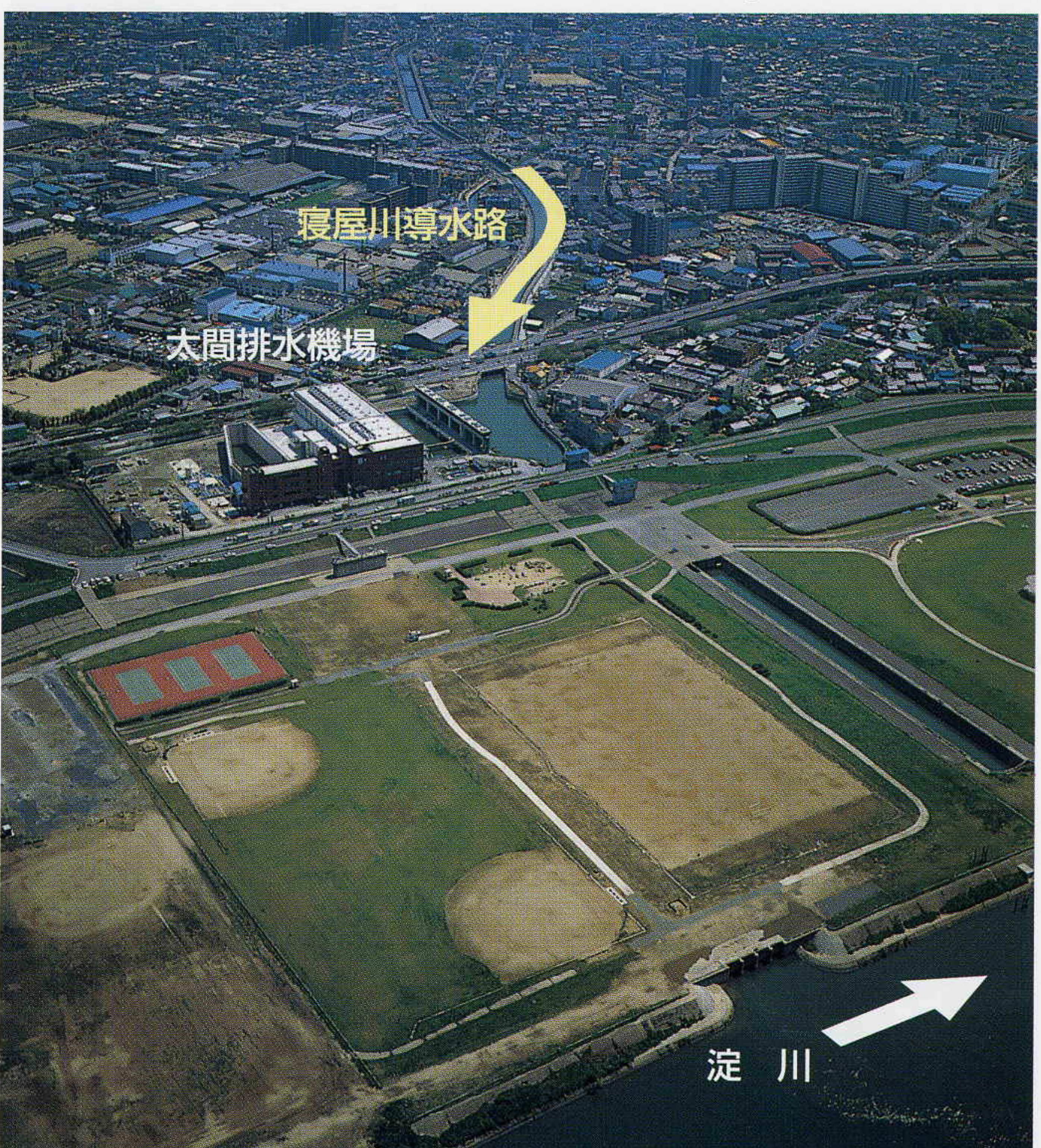
太間排水機場
