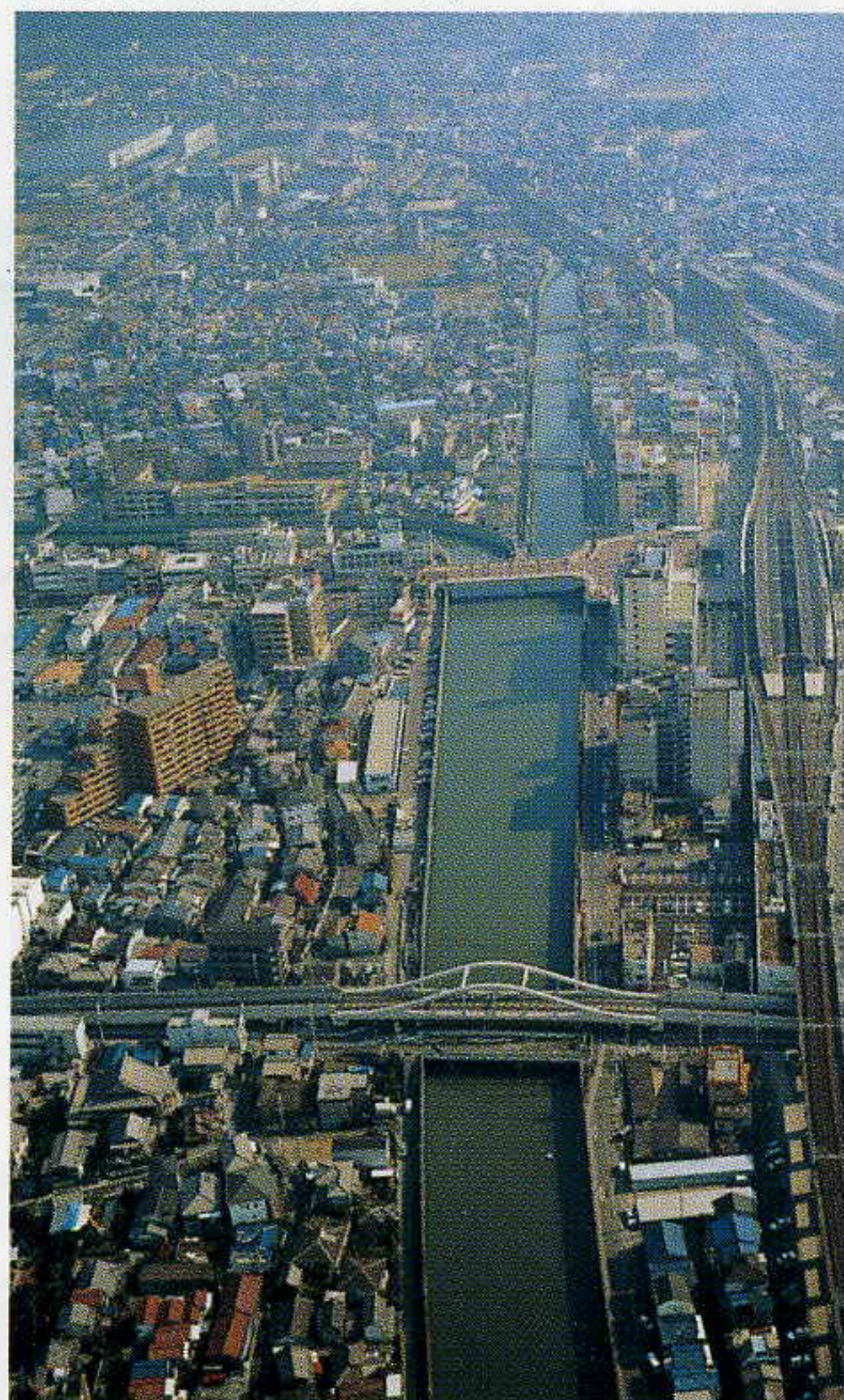
改修後(平成12年)
