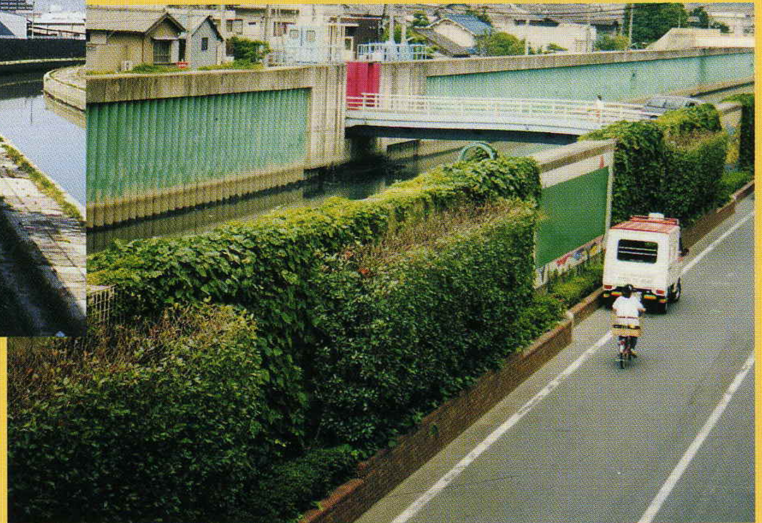
護岸垂直緑化(恩智川住道新橋付近)
