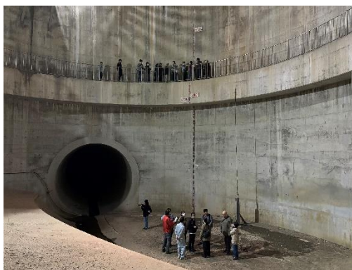
▲実際に、中に入って立坑の見学！！ ▲普段見れない治水施設の規模の大きさを体感できます☆
