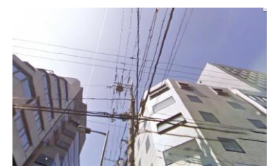
電線類の全面地中化
