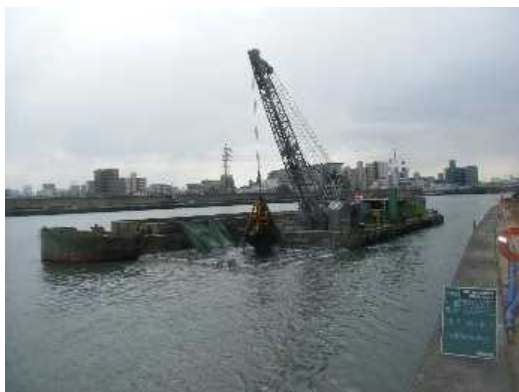
神崎川河床掘削工事
