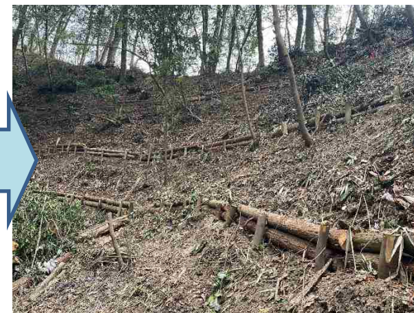
②森林整備（筋工） 施工前後
