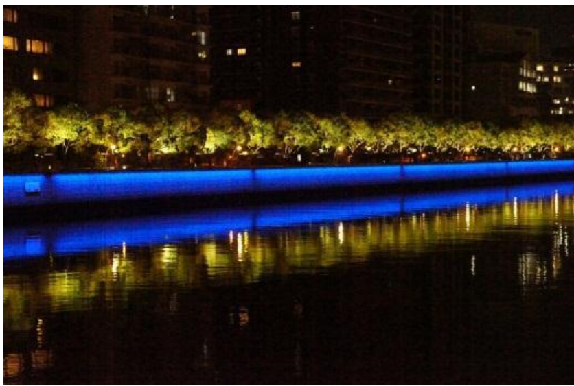
国際会議場前護岸のライトアップ(H22)
