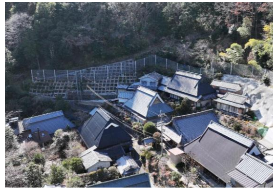
奥今滝(1)地区 急傾斜地崩壊対策事業（※⑨）高槻市 【令和7年度概成】
