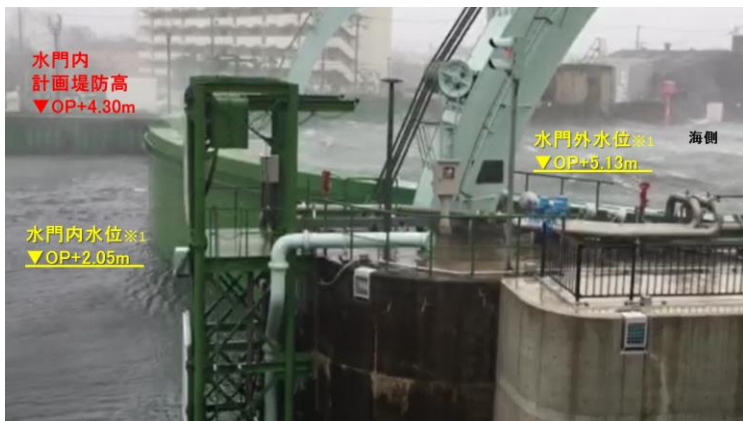
▲平成30年台風第21号到来時の木津川水門
