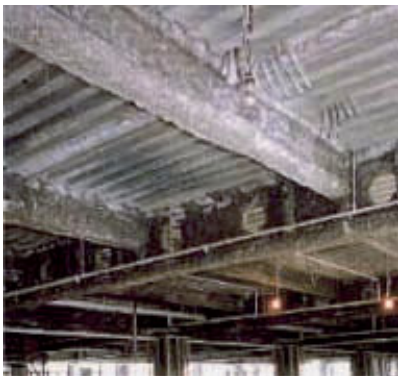
耐火被覆材（柱・梁など）
