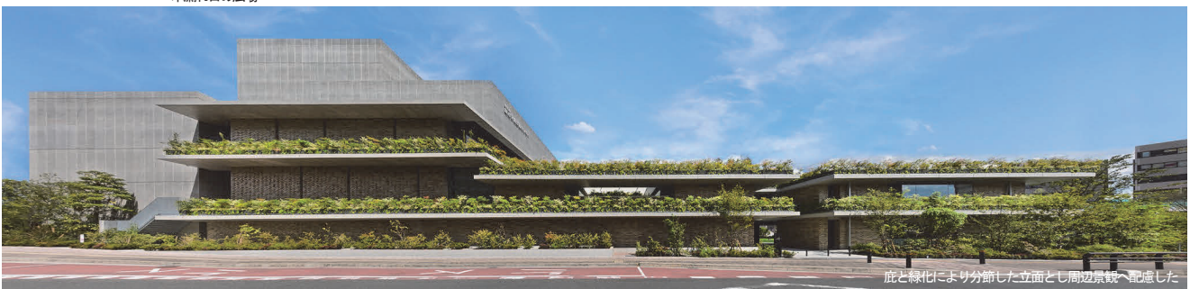
庇と緑化により分節した立面とし周辺景観へ配慮した
