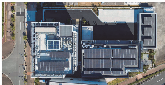
屋上設置の太陽光パネル (左から管理棟・実験棟・駐車場棟)
