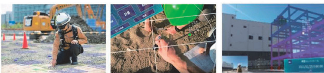
現地での投影データによる杭芯出し
