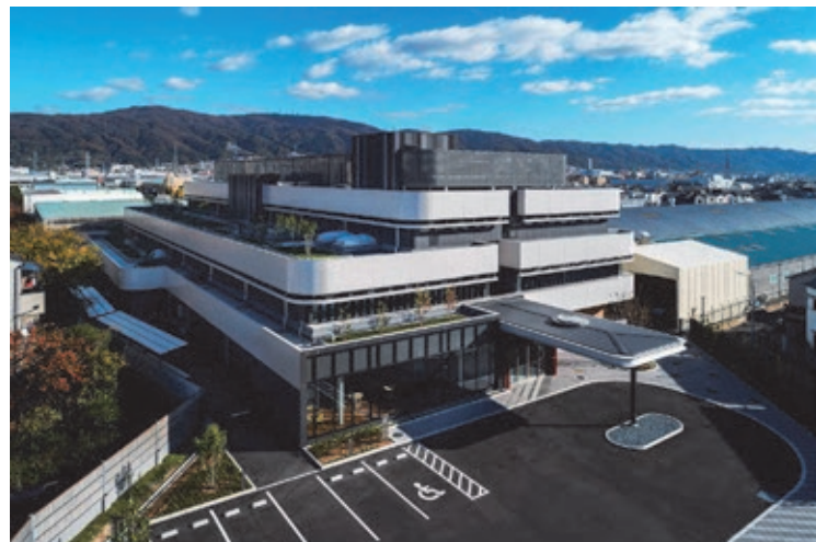
西側外観 ひな壇状にセットバックした屋上には緑化を行った。
