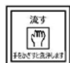
○光感知式の洗浄スイッチは、視覚障がい者には使いにくい設備であるため、押ボタン式スイッチと併用する。
