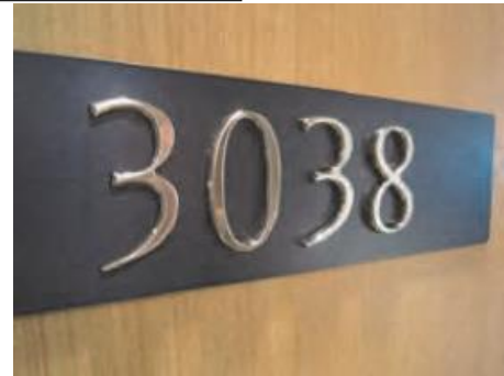
室番号の浮き彫り表示の例
