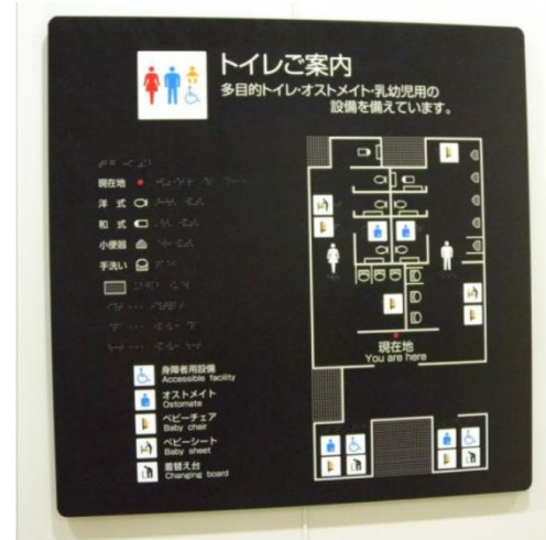
○便所の触知図案内板の設置例
