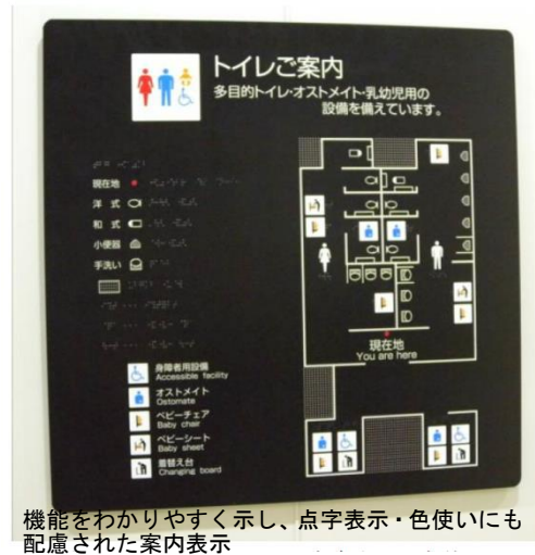
○便所の触知図案内板の設置例
