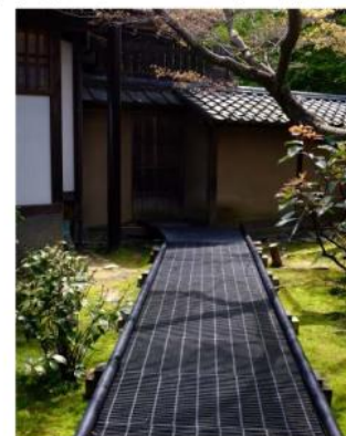
図6 坪庭に設置された車いす用ルート
