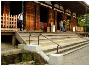
図3 仮設の手すり
