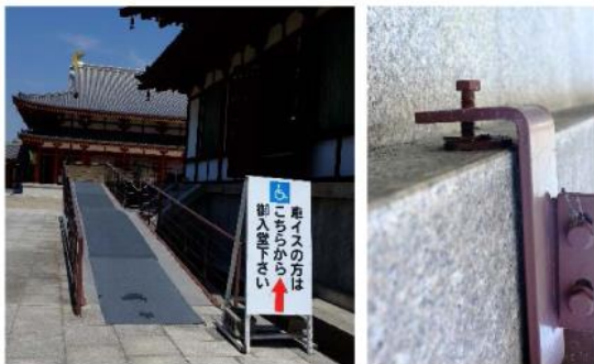
図2 基壇への仮設スロープの設置
