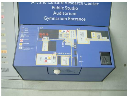
○図 13.2 触知図案内板の例
