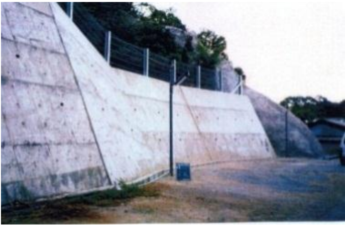
急傾斜地崩壊防止施設
