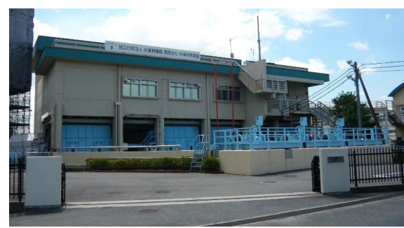
高見排水機場
