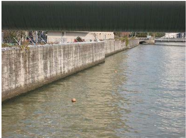
L型擁壁 堂島川
