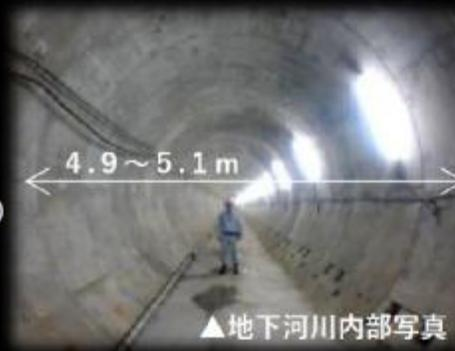
寝屋川北部地下河川は、すでに供用中の貯留容量と合わせて、26万立方メートルの雨水貯留が可能となります。
