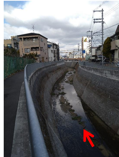
前川改修工事（65mm対策）完成
