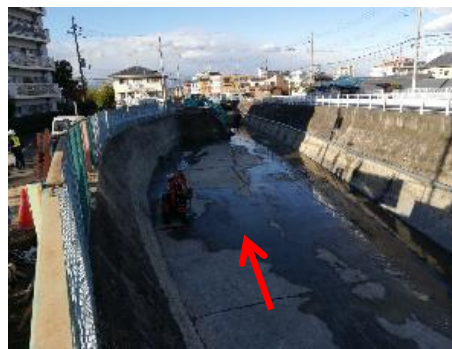
傍示川（砂溜工）
