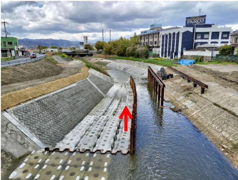
穂谷川改修工事（80mm対策）施工中
