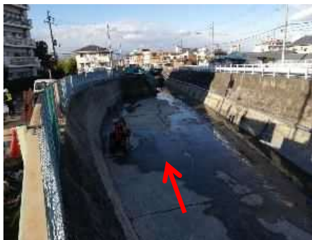
傍示川（砂溜工）
