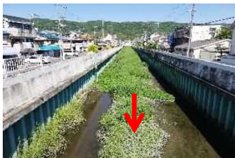
【河川堆積土砂除去など】
