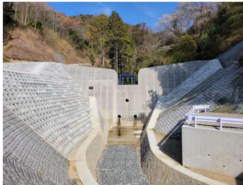
砂防堰堤の完成（R8.3月）
