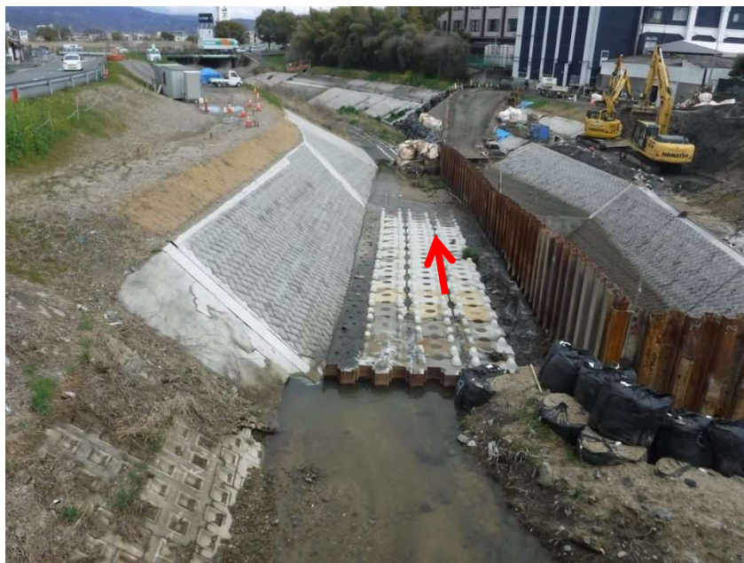
穂谷川改修工事（80mm対策）施工中
