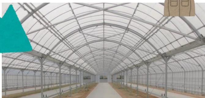
X型の斜材による補強
