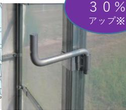
妻面のドアが破られ、風によりハウス全体が上部に浮き上がらないようカンヌキを設置します。設置すると耐力が約30%アップします(※)。
