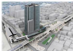
羽衣駅前地区 市街地再開発事業 出典：高石市HP
