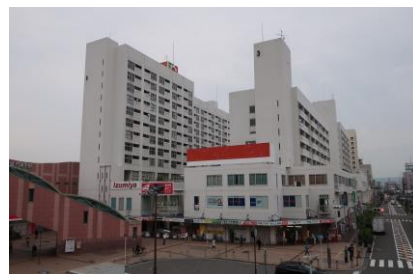
門真プラザビル（門真市） 提供：大阪府
