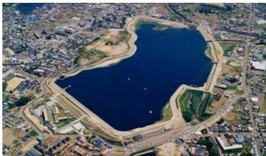
狭山池ダムは治水容量100万m<sup>3</sup>の洪水調整機能を持っているが、事前放流を行うことで46万m<sup>3</sup>の洪水調整機能の追加をすることができる。
