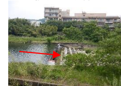
上一之井堰魚道整備(富田林)
