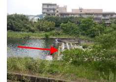
上之井堰魚道整備(富田林)
