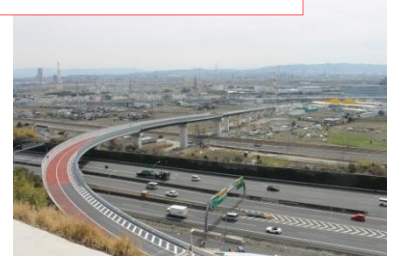
高槻東道路（新名神高速道路アクセス） （2017.3 供用開始）
