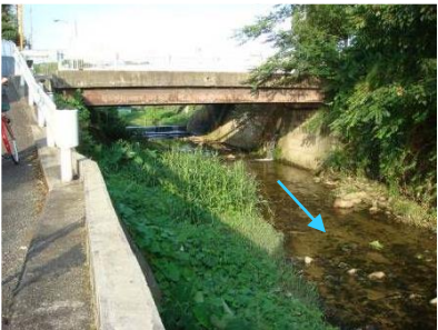
改修前(新上渡場橋下流)
