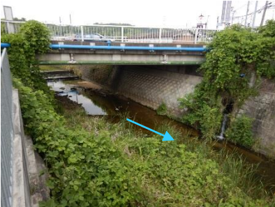
改修後(新上渡場橋下流)
