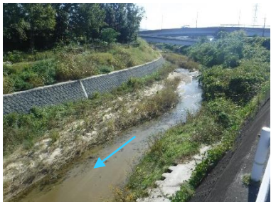
改修後(出屋敷橋上流)
