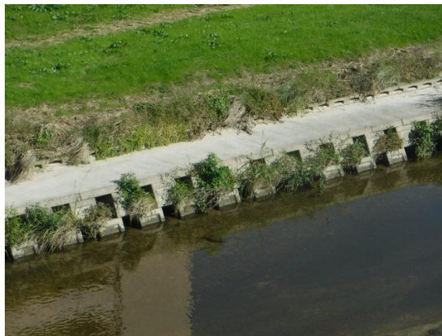
天野川:低水護岸に魚巢ブロックを採用
