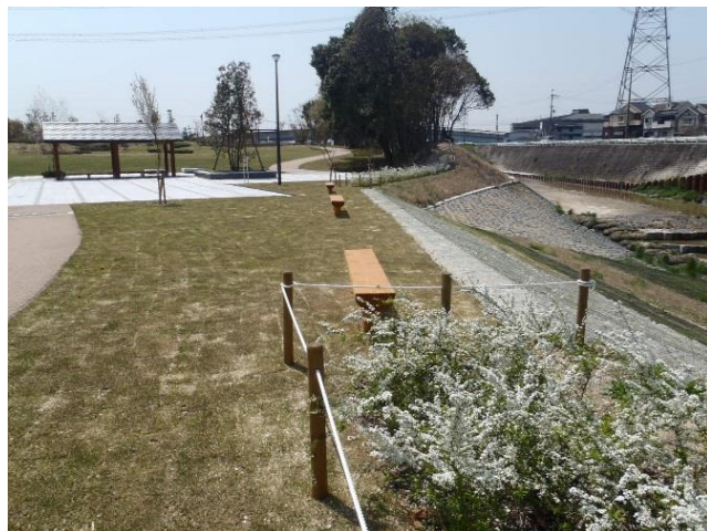
穂谷川: 芝生緩傾斜護岸(川原広場)
