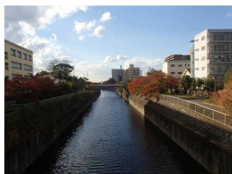
図-1.18 住吉川水門上流側
