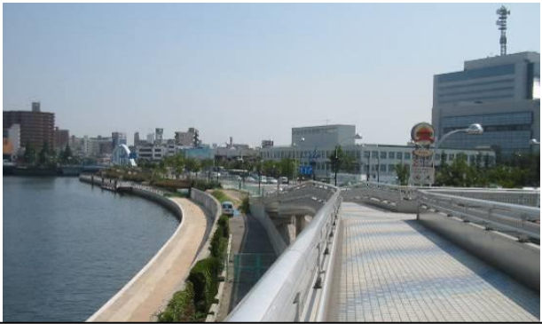
図 1.53 木津川・尻無川スーパー堤防区間 （木津川右岸）
