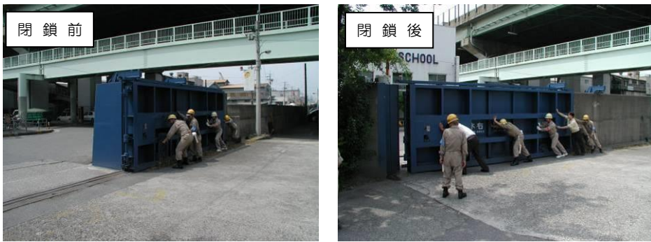
図 1.76 防潮鉄壁（水防訓練の様子）
