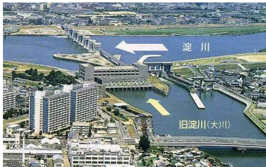
図 1.75 毛馬排水機場
