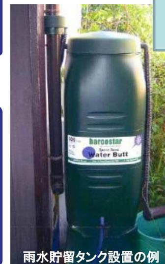
雨水貯留タンク設置の例
